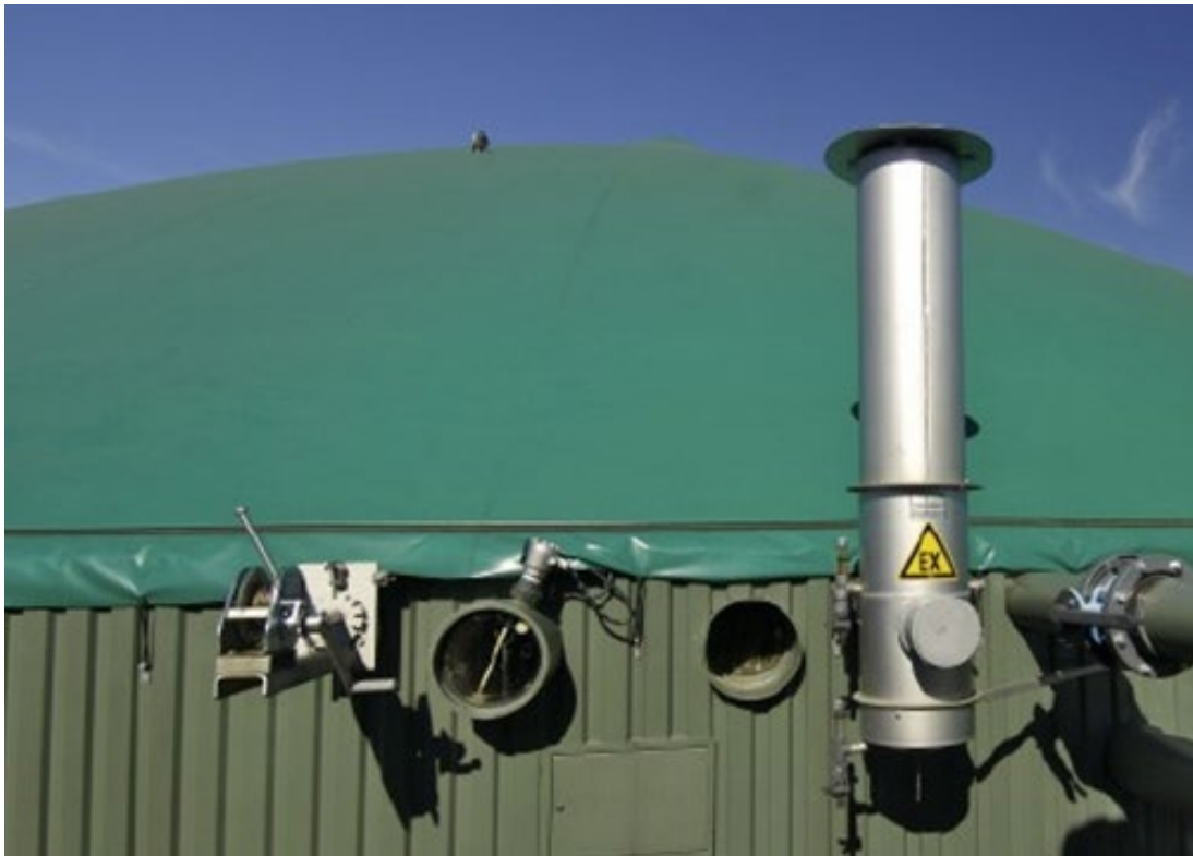
图 2-3：正负压保护器
