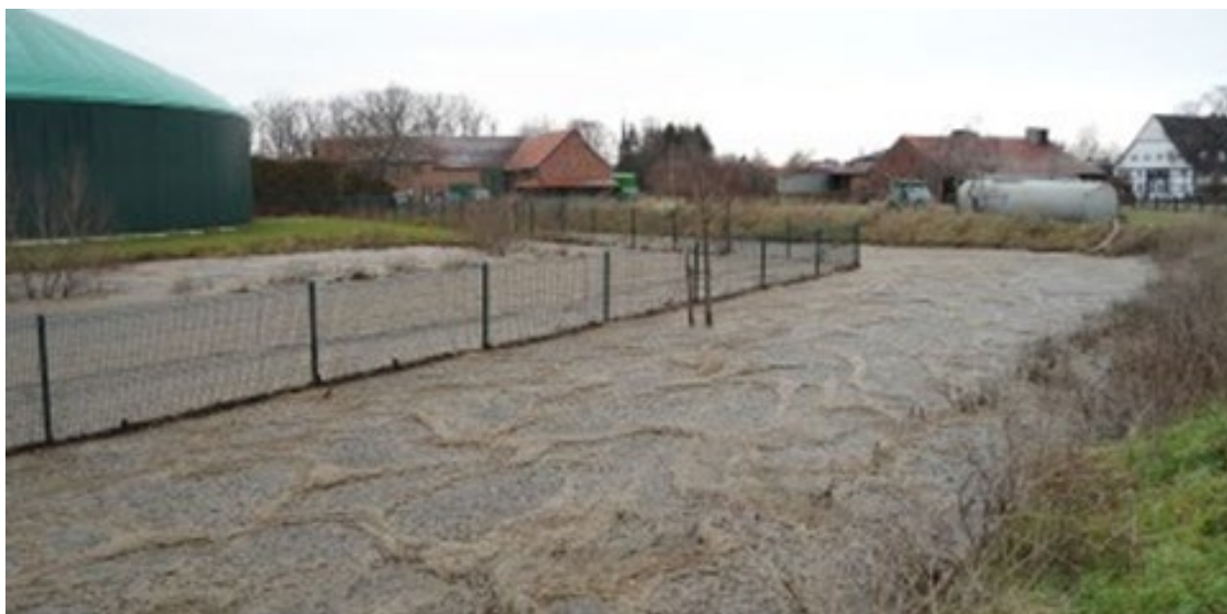
图 2-9 沼气厂泄露事故图
