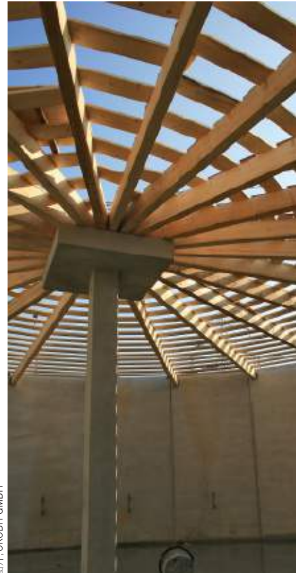
消化池的木质屋顶结构
