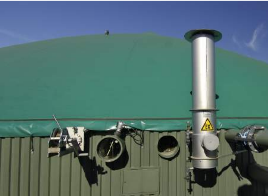
发酵罐上的正负压保护装置
